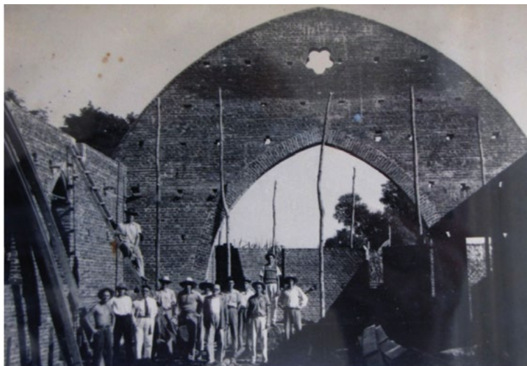
FIGURA 135: Construção da capela da Comunidade Luterana São Paulo, em Arroio do Meio
