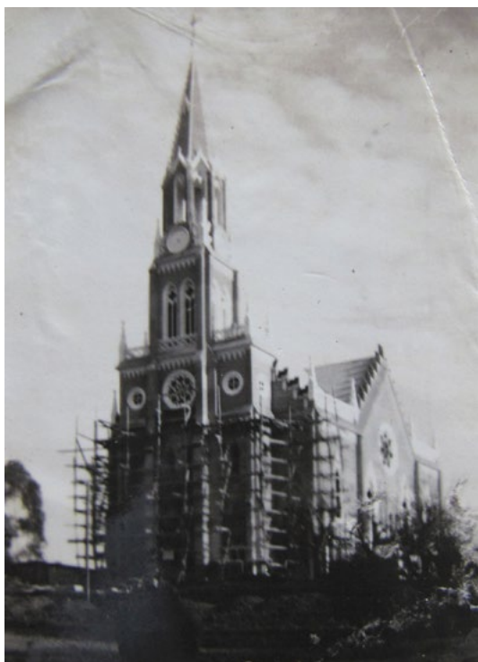
FIGURA 131: Construção de Igreja Matriz, de Arroio do Meio, entre 1938 e 1940 Fonte: Acervo fotográfico do Museu Público Municipal de Arroio do Meio (2010).
