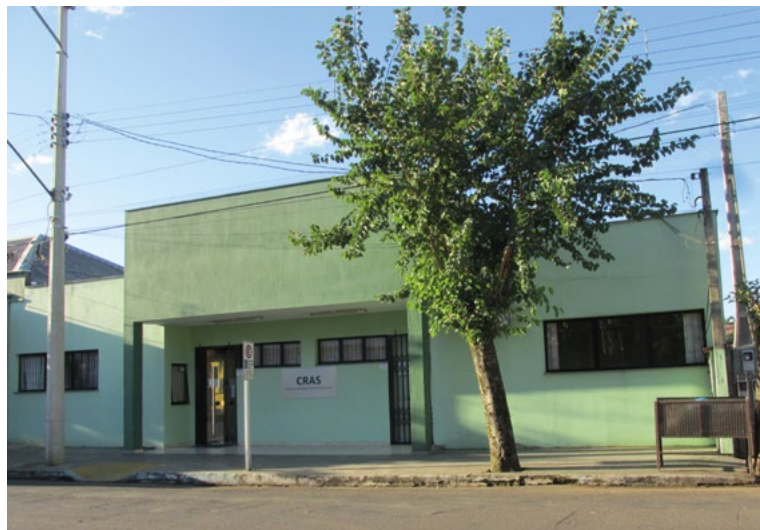
FIGURA 186: Prédio do Centro de Referência em Assistência Social de Arroio do Meio Fonte: Acervo fotográfico da Prefeitura Municipal de Arroio do Meio (2019).
