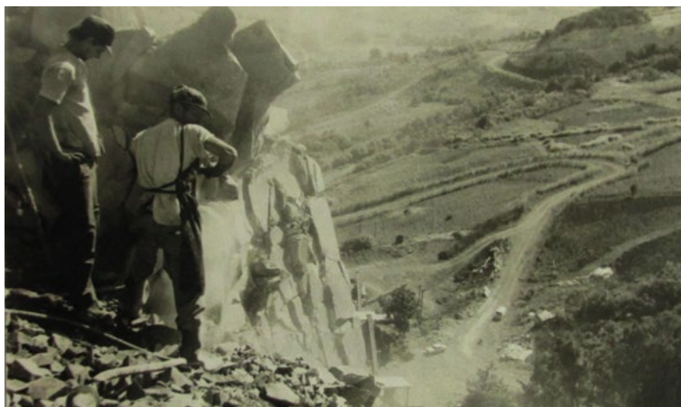
FIGURA 213: Extração de pedras no Morro Gaúcho
