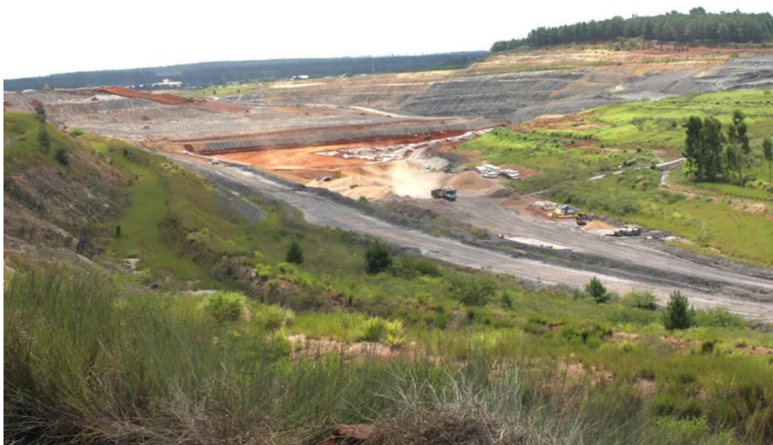
Figura 25. Aterro Sanitário – SIL Soluções Ambientais – Minas do Leão/RS
