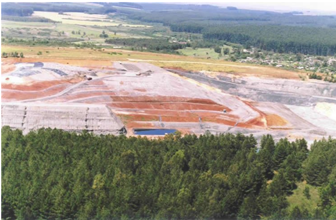
Figura 27. Aterro Sanitário – SIL Soluções Ambientais – Minas do Leão/RS
